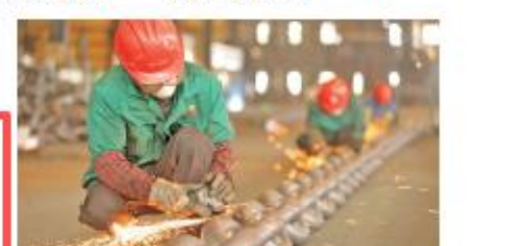
8月25日，青岛稀贵金属资源循环利用项目施工现场，工人正在对设备进行调试。
