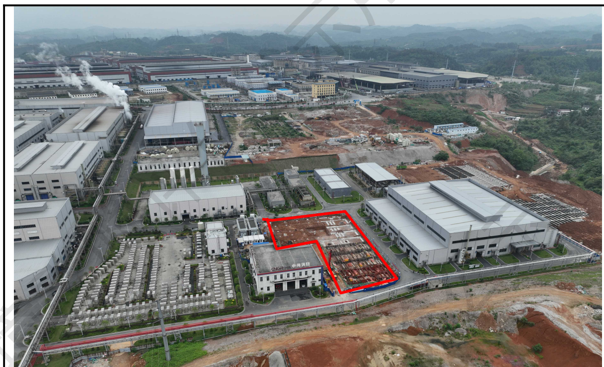
项目全厂南侧用地现状全貌
