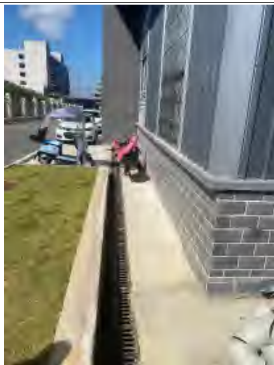
厂区外雨水沟
