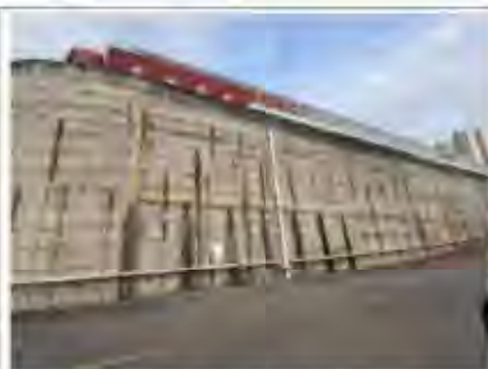
生产废水管道
